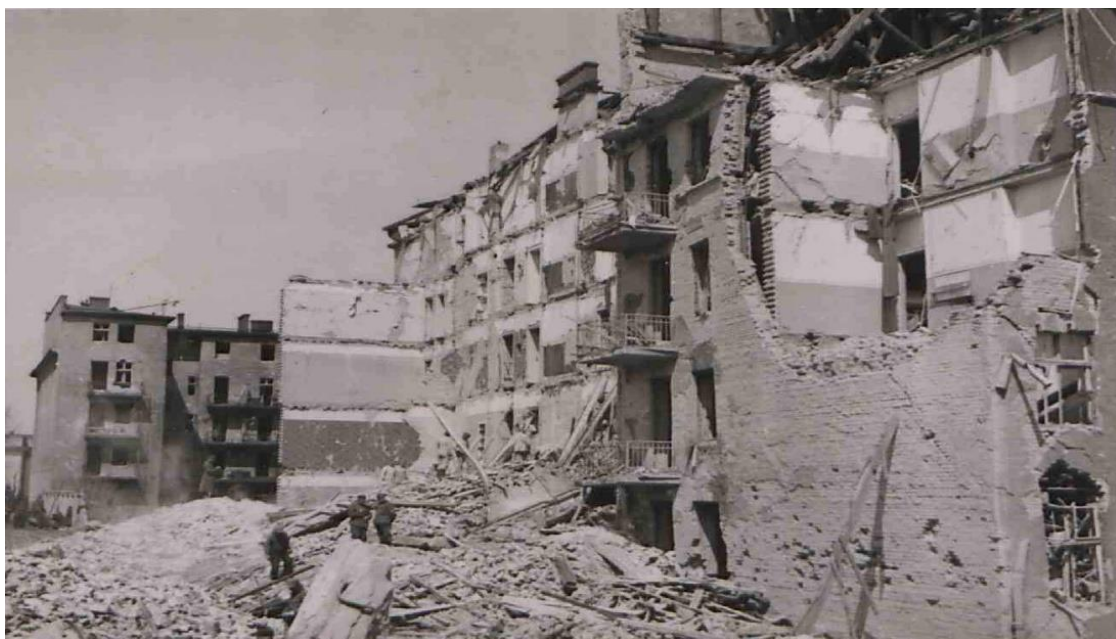
Fot. 1. Zniszczone kamienice przy ul. Śniadeckich
